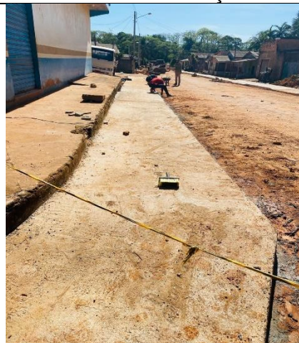
Foto 04: CONCLUSÃO DAS CALÇADAS
