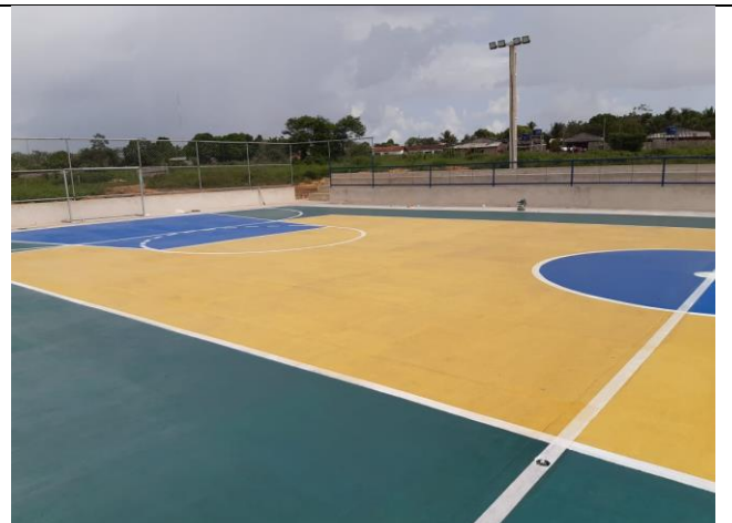
Foto 02: CONCLUSÃO ELETRICA E PINTURA.
