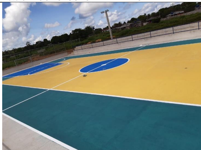
Foto 03: CONCLUSÃO ELETRICA E PINTURA.
