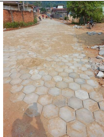
Foto 02: CONCLUSÃO DOS BLOQUETES RUA EVERALDO MARTINS
