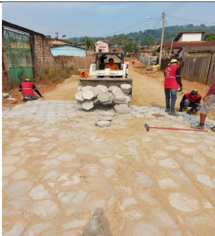
Foto 01 : CONCLUSÃO DOS BLOQUETES RUA EVERALDO MARTINS
