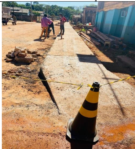
Foto 03: CONCLUSÃO DAS CALÇADAS
