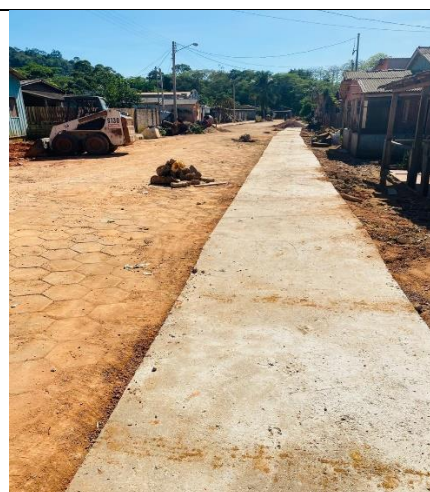
Foto 02: CONCLUSÃO DAS CALÇADAS
