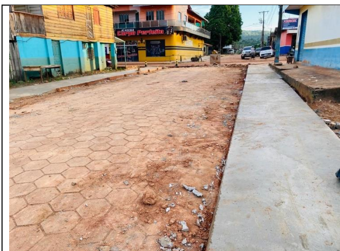
Foto 01 : CONCLUSÃO DAS CALÇADAS
