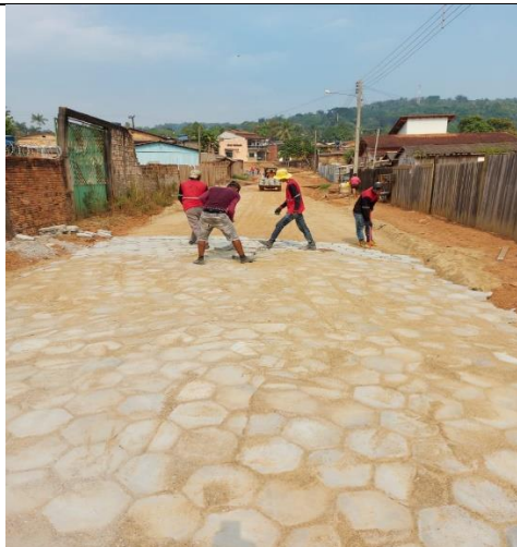
FOTO 03: CONCLUSÃO DOS BLOQUETES RUA EVERALDO MARTINS
