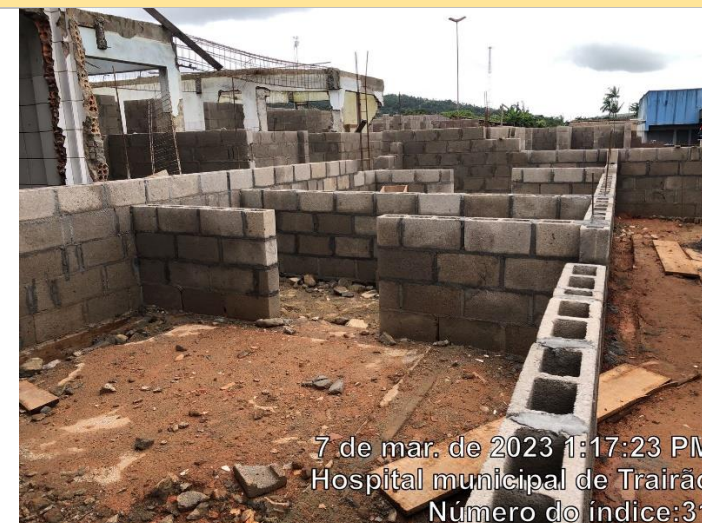
2 – Demolição de alvenaria em tijolo cerâmico antigo, demolição de concreto armado, rasgo em piso. Viga baldrame concretada, assentamento de alvenaria em bloco de concreto iniciada
