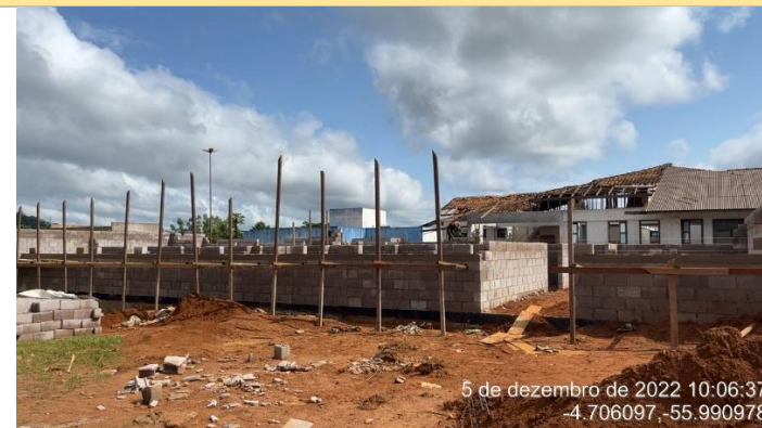
1 – Alvenaria de vedação e bloco de concreto, demolição de alvenaria antiga, impermeabilização de viga baldrame
