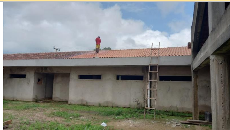
2 – Limpeza de terreno e limpeza de telhado. Águas pluviais, impermeabilização de calhas, reboco.
